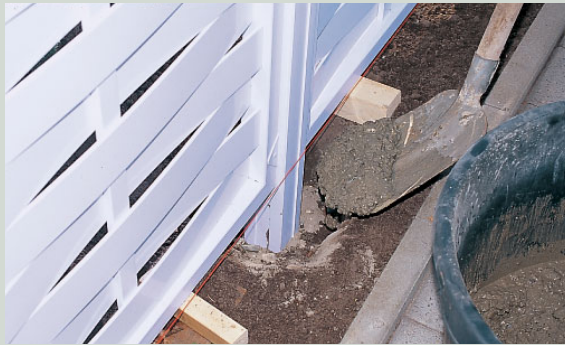
Zaunpfosten direkt ins Erdreich einbetonieren...
